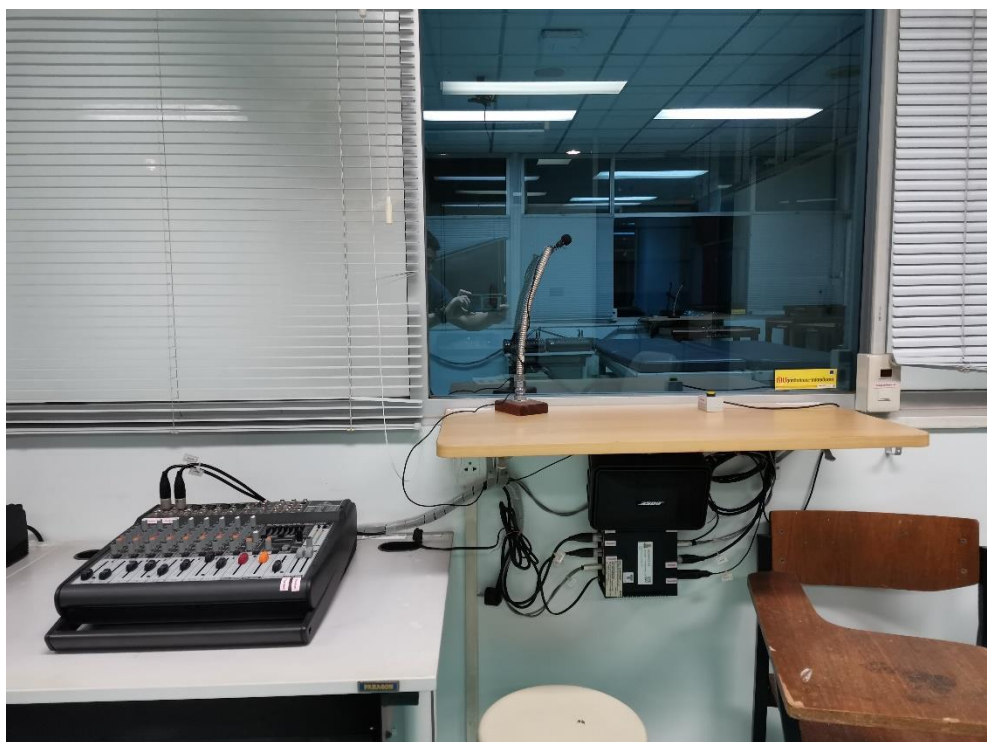
ภาพแสดงระบบเครื่องเสียงสื่อสารห้องสังเกตการณ์
