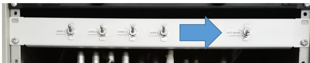
ภาพแสดงแผงควบคุมพื้นที่กระจายเสียง
